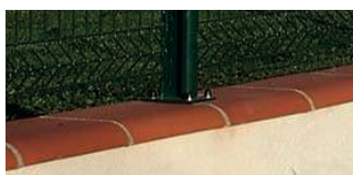
Poteau soudé sur platine
